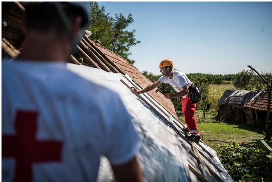
Tető helyreállítása Megyaszón
